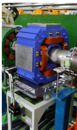
図 4：トンネル内に設置されたスクュー四極電磁石
