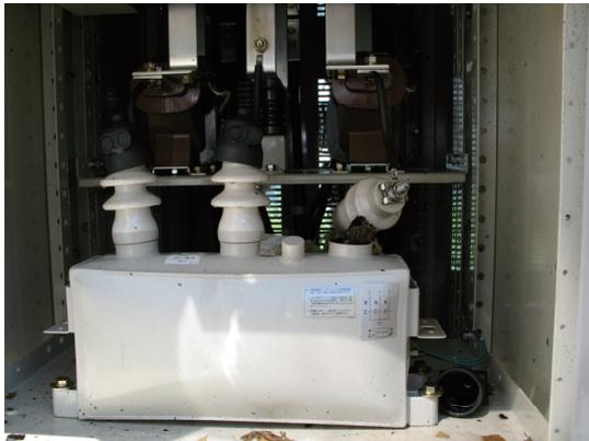
図3 損傷したサージアブソーバ
