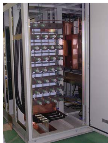
図 6 : キッカー電源 P FN 部 (改造後)
