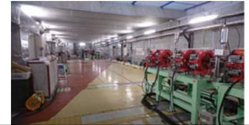
改造部の機器撤去 (2019年12月初)
