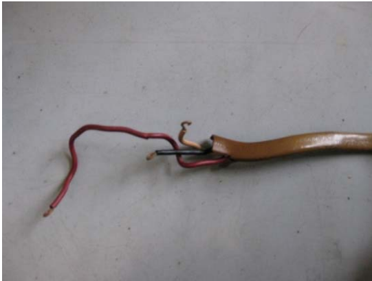
放射線により硬化した VVFケーブル
