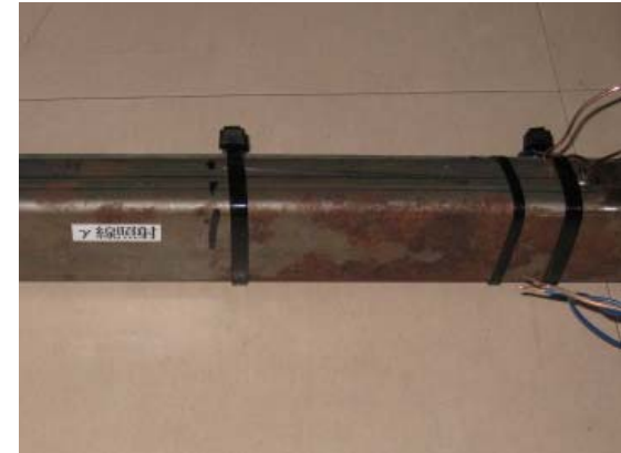
錆が発生した 鉄のボックス
