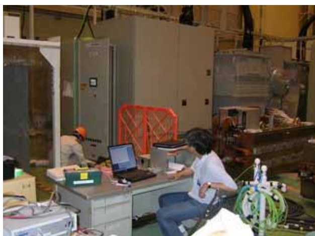
図 2: 速い取り出しのセプタムの電源試験
