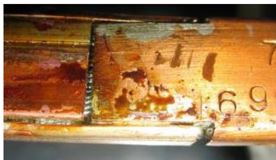
接続不良の例
