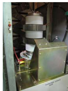
サイラトンの設置
